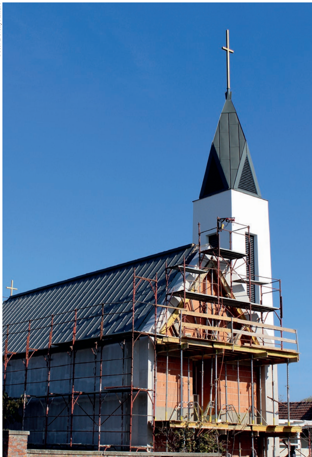
Az épülő templom – Okány, 2025
